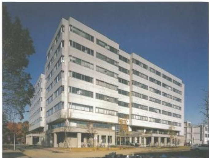
材料・化学棟 (南西より)
